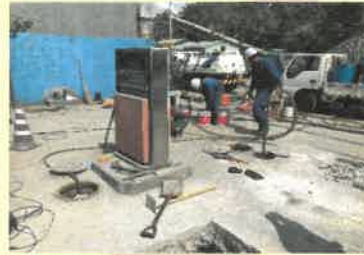
タンク施工中
