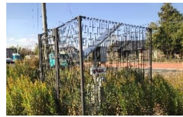
道路脇には線量計が設置
