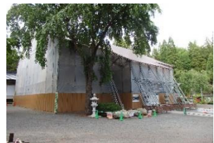
天台寺の外見(工事中)
