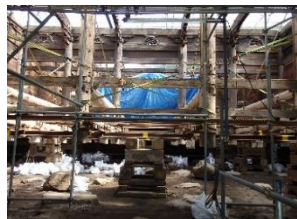
内部では細心の注意を払い工事が進められている。地面に点々と見えるのが礎石。
